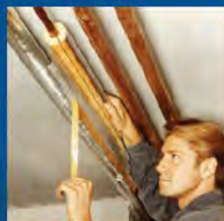
Rohrleitungsdämmung
