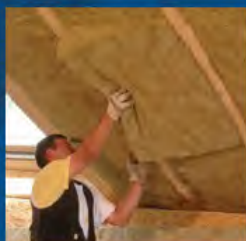
Dämmung zwischen den Sparren
