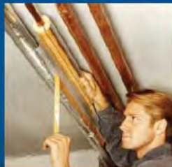
Rohrleitungsdämmung
