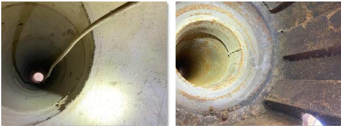
Abbildung 5-1: Schornsteinzüge am Heizungsgebäude (Gebäude 4) – Innenansicht
