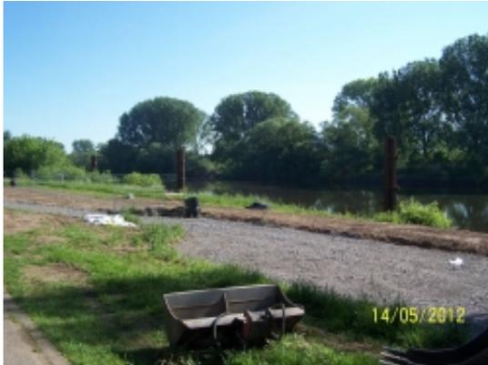
Bereits im letzten Jahr wurde in Mainflingen die bestehende Böschungsliegestelle zu einem zeitgemäßen, den technischen Standards für Liegestellen entsprechenden Dalbenliegeplatz instandgesetzt. Die Liegestelle bietet so zukünftig 2 x 110 m Schiffslängen Platz, damit Schiffsruhezeit eingehalten werden können.
