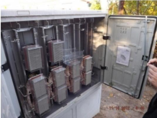
Der Breitbandausbau in den Mainhausener Ortsteilen Mainflingen und Zellhausen schreitet voran. Die Anbindung erfolgt über eine sogenannte Hybrid Lösung. Das DSL Signal wird mittels Richtfunk an die Ortseingänge transportiert und von dort über einen Outdoor DSLAMs in Schaltverteiler geleitet, die wiederum die Verbindung zum Kupferkabel der Telekom herstellen.
