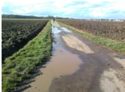
Durch das regelmäßige Mulchen der Feldwegränder kommt es sukzessive dort zu Aufhöhungen. Dadurch kann bei stärkeren Regenfällen das Wasser von der befestigten Fahrbahndecke nicht mehr ablaufen. Außerdem breitet sich die Vegetationsdecke immer mehr auf die Wegefläche aus.
