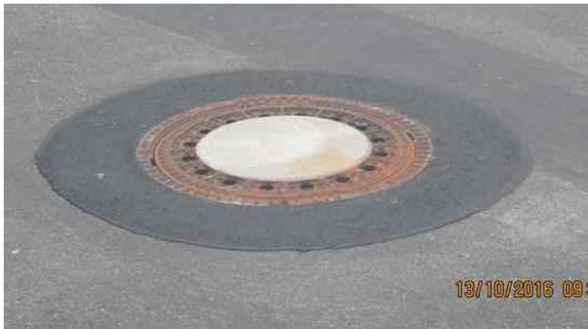
Nach einigem Hin- und Her wurden diese Mängel jetzt endlich behoben. Eine Fachfirma hatte in dieser Woche, im Auftrag der EVO, begonnen die betroffenen Kanalschächte zu sanieren. Dazu wurden die beschädigten Kanalschächte angehoben und neu eingestellt, sodass die Kanaldeckel nun ebenerdig liegen und nicht mehr beim Überfahren klappern.
