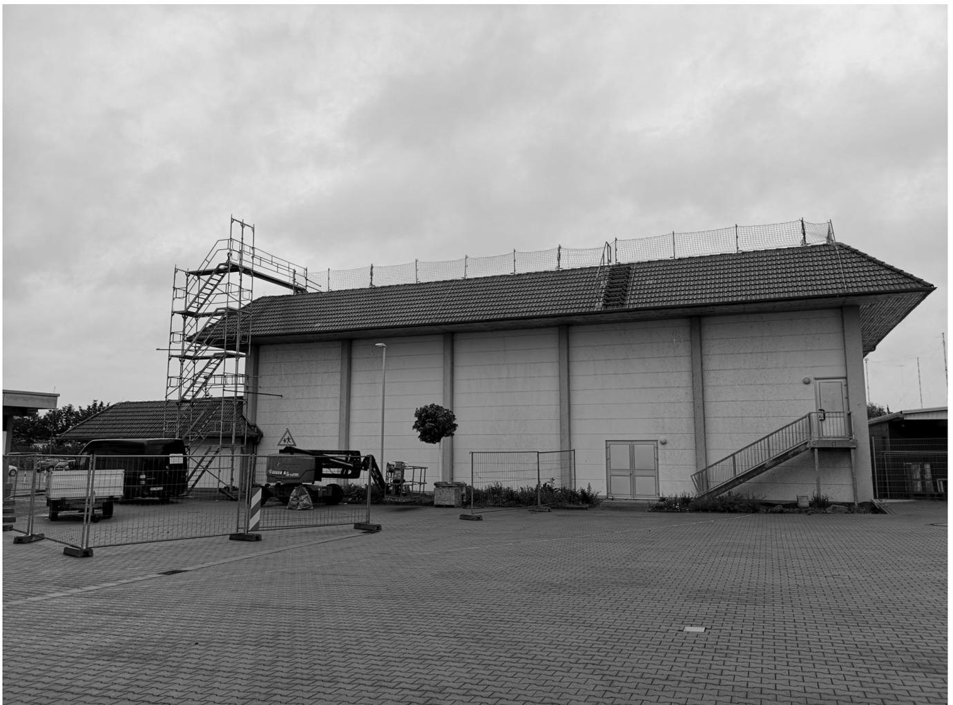
Nicht ganz unerheblich ist dabei der Rückbau des mehrlagigen Gründachaufbaus und die bestehende Abdichtung inklusive Wärmedämmung. Dieser Rückbau erfolgt mit Luftfördertechnik und im Weiteren tatsächlich händisch. Anschließend wird eine neue Gefälledämmung und Dachabdichtung verbaut und in diesem Zuge auch die Dachentwässerung den aktuellen Anforderungen angepasst.
