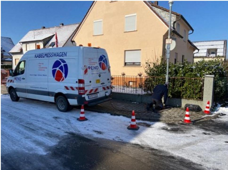
Mit den eigenen Messgeräten, die bis zu 1.000 V Isolationsmessungen ermöglichen, konnte der Verlauf und die Tiefe des Kabels bestimmt werden. Allerdings war es erst mit Hilfe des Messwagens der ENO Offenbach möglich, mit Hilfe einer Sonde den Fehler auf ein Umfeld von 0,5 Meter einzugrenzen.
